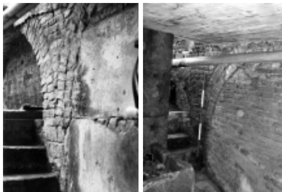
Figura 6: Fotografías del mismo arco, en 1985 y en 2005, útil para modificar la atribución del Edificio al Polvorín de Cueli, que consideramos incorrecta.
