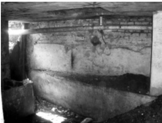
Figura 5: Vista actual mostrando el arco estudiado en 1985 tras su limpieza en 2005.
